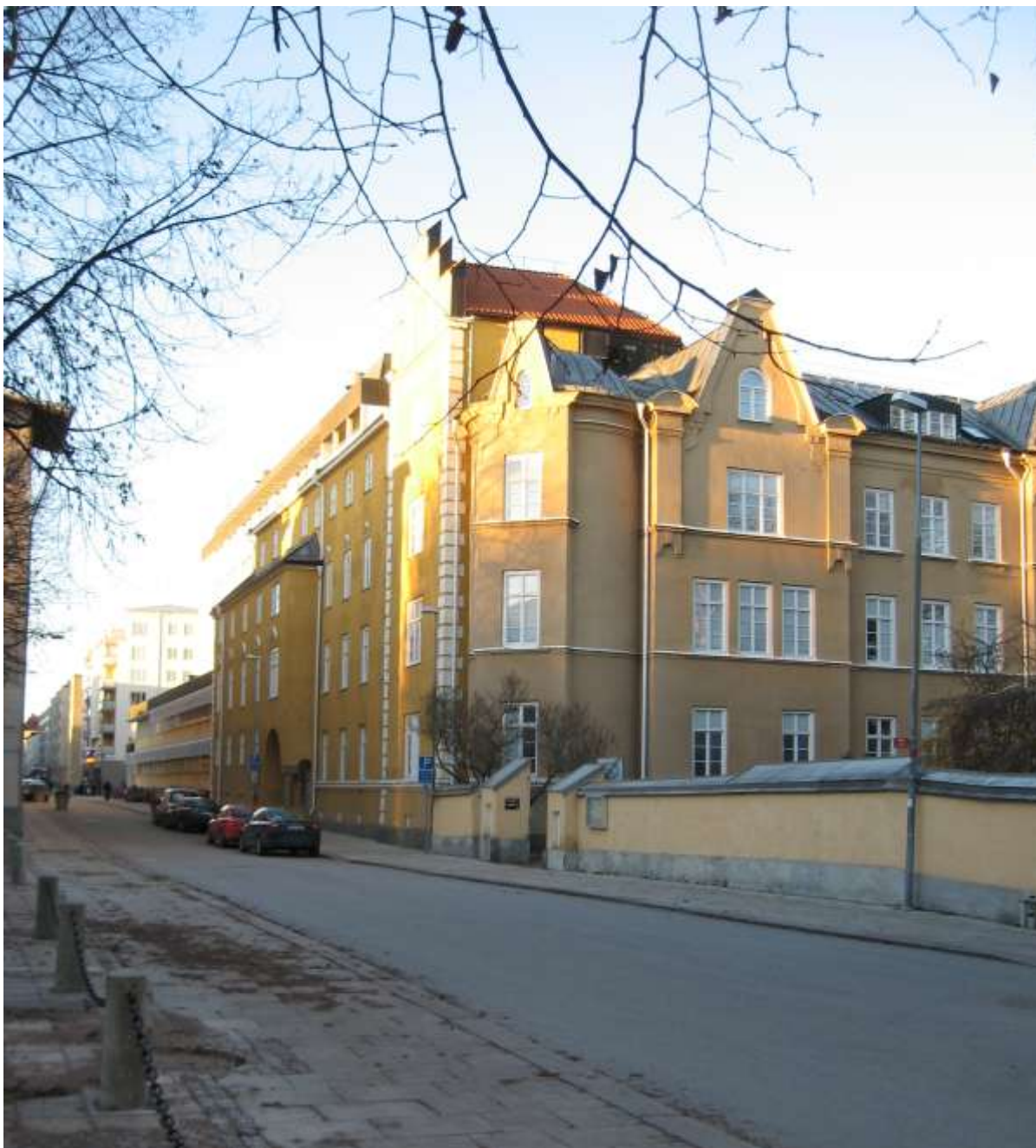
Det gamla sjukhusets huvudfasad mot Kungsängstorg samt den om- och nybyggda delen mot Dragarbrunnsgatan
